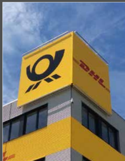
DHL Paketzentrum, Frankfurt Stretchbox übers Eck
