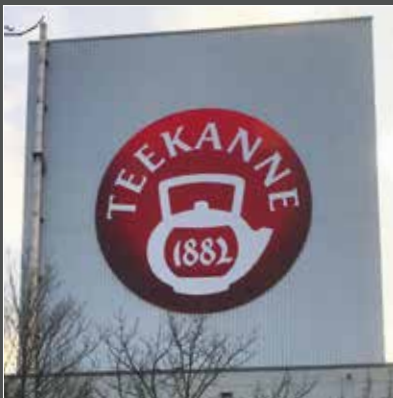
Teekanne, Essen Aluverbundplatten mit Digitaldruck, mehrteilig, kreisförmig gefräst
