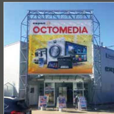
Octomedia, Rastatt Bannerlift auf Gerüst montiert
