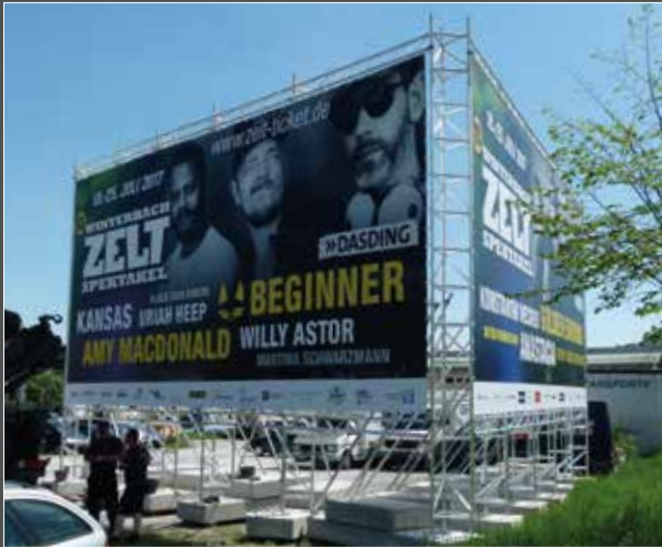
Zeltspektakel, Winterbach Bauschild-Unterkonstruktion mit Banner
