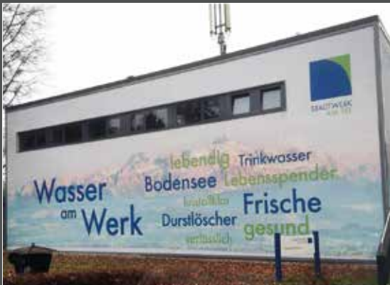
Stadwerke am See, Friedrichshafen Angle mit Ausschnitt für Fenster
